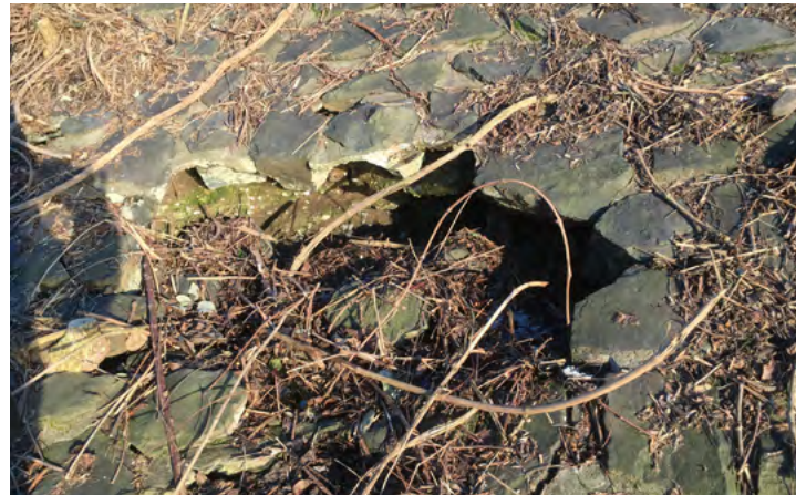
Jan. 2019, 2. Rodungsabschnitt, Besichtigung durch Dipl.-Biologe R. Leiders: Pflasteraufbruch, typische Auskolkung mit Verlust der Magerbeton-Unterlage. Auch dieser Schaden dürfte viele Jahre alt sein.
