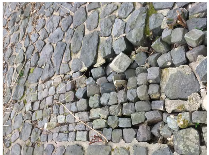
April 2019, 2. Rodungsabschnitt, Besichtigung d. Prof. H. Schüttrumpf: Weiteres Beispiel für unfachmännisches Flickwerk mit Straßenpflaster.
