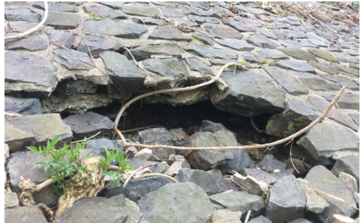
April 2019, 2. Rodungsabschnitt, Besichtigung d. Prof. H. Schüttrumpf: Erkennbare tiefe Auskolkung und Verlust des Unterbettes. Auch dieser Schaden ist sehr wahrscheinlich älter als zehn Jahre.
