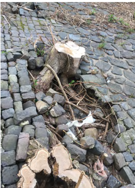
← April 2019, 2. Rodungsabschnitt, Besichtigung d. Prof. H. Schüttrumpf: Vollkommen verwahrloste Fläche, hier hätte das zuständige Amt vor über zehn Jahren aktiv werden müssen. Zu erkennen auch ältere Flickversuche mit Straßenpflaster ohne entsprechendes Unterbett.
