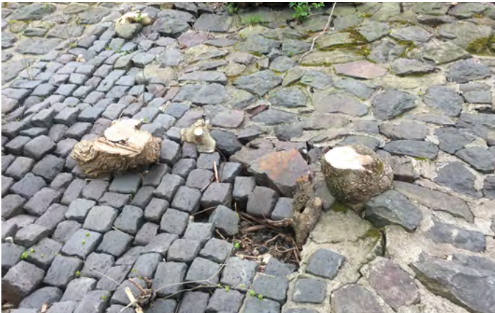
April 2019, 2. Rodungsabschnitt, Besichtigung d. Prof. H. Schüttrumpf: Beispiel für unfachmännisches Flickwerk mit Straßenpflaster
