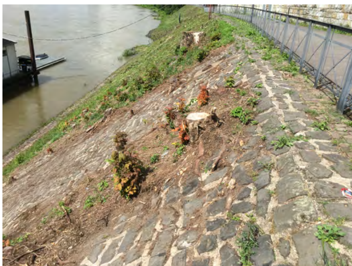
Juni 2018, 1. Rodungsabschnitt nach Säuberung: Keine Schäden durch Baumwurzeln erkennbar
