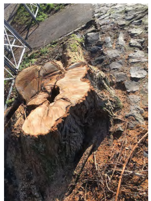
→ Jan. 2019, 2. Rodungsabschnitt bei RKM 693, Besichtigung durch Dipl.-Biologe R. Leiders: Selbst größere Stämme hatten sich ohne größere Schäden an der Pflasterdecke in diese eingefügt. Nach diesem Schnitt wird der Stumpf mittelfristig verrotten, die Pflasterdecke einbrechen.
